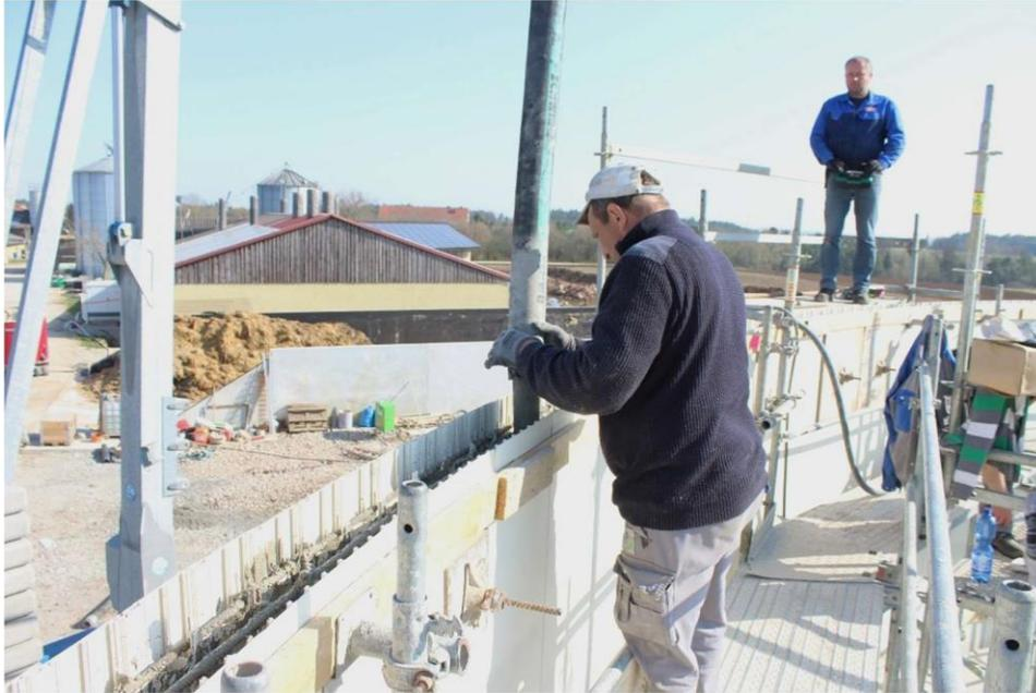
Abbildung 19. Betonieren der Behälterwand
