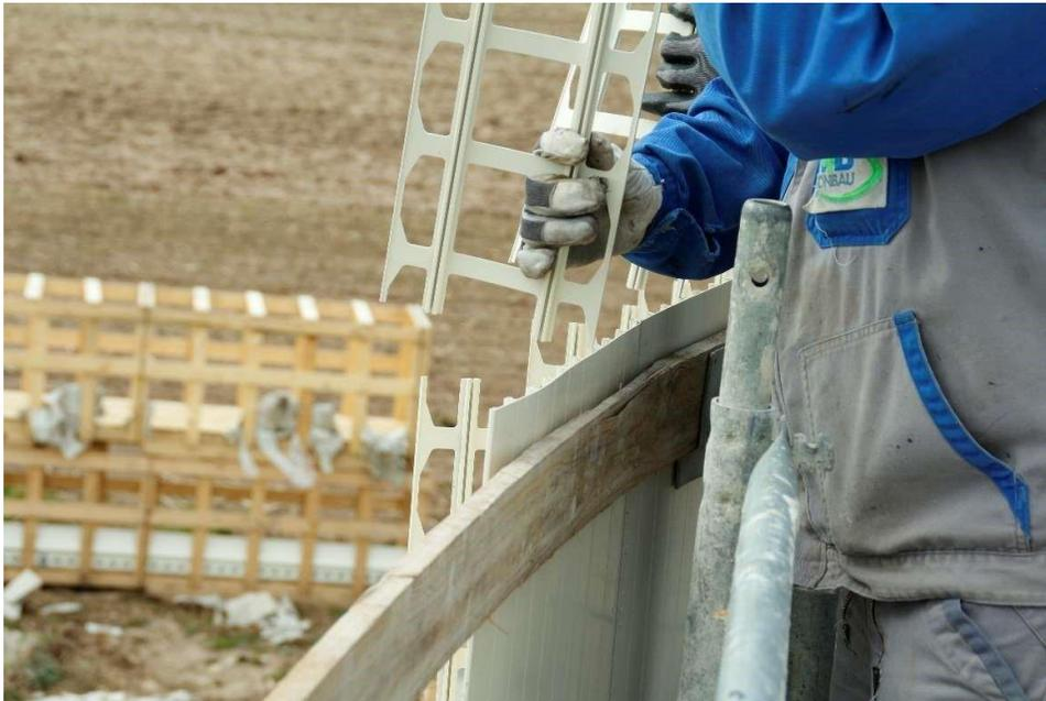
*Abbildung 8. Montage Konnektoren*
