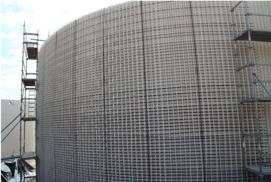
*Abbildung 14. Fertig armierte Behälterwand*
