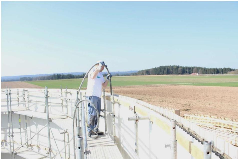
Abbildung 20. Verdichten des Betons mit Rüttelflaschen
