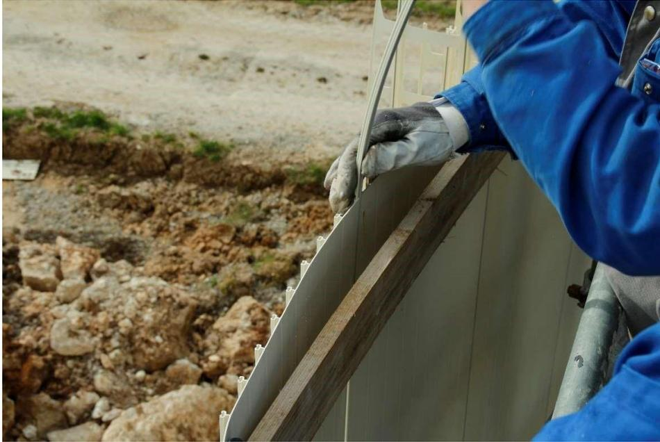
*Abbildung 7. Montage Verbinder für Innenpaneele*
