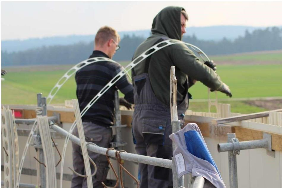
*Abbildung 17. Montage 45° Versteifungen an Außenpaneelen*
