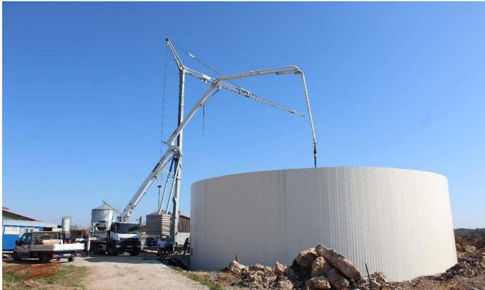
*Abbildung 21. Befüllung der Schalung mit Beton*
