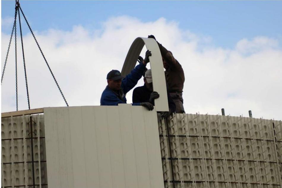
*Abbildung 16. Montage der Außenpaneele*
