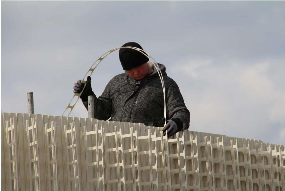
*Abbildung 9. Montage 45° Versteifungen*
