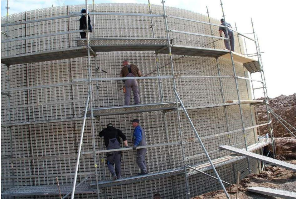
*Abbildung 13. Montage der vertikalen Bewehrungsstäbe*
