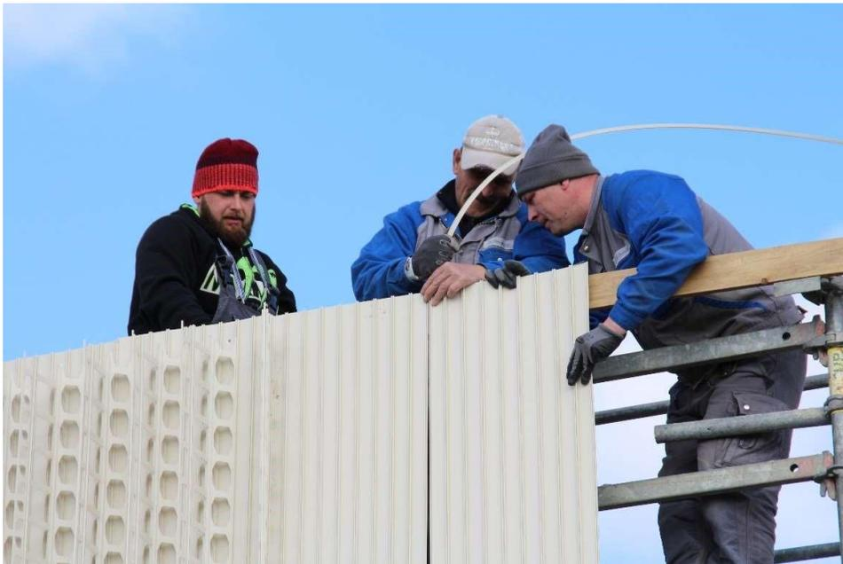
*Abbildung 6. Montage Verbinder für Innenpaneele*
