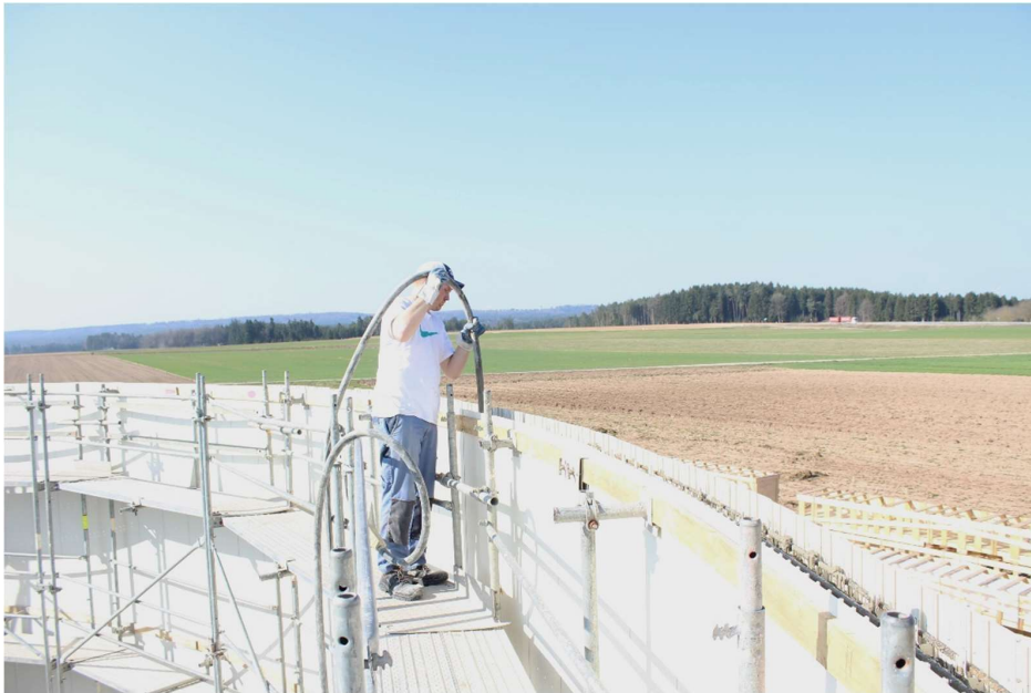
Abbildung 20. Verdichten des Betons mit Rüttelflaschen
