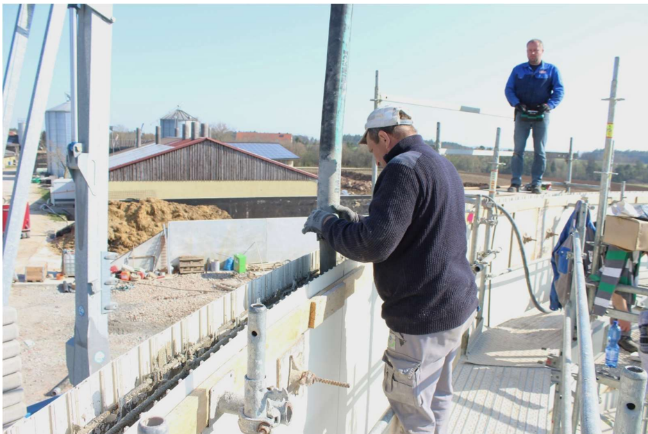
Abbildung 19. Betonieren der Behälterwand
