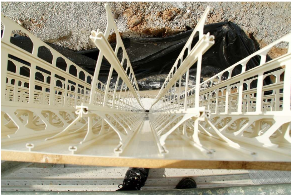
Abbildung 10. Fertig montierte Innenschalung
