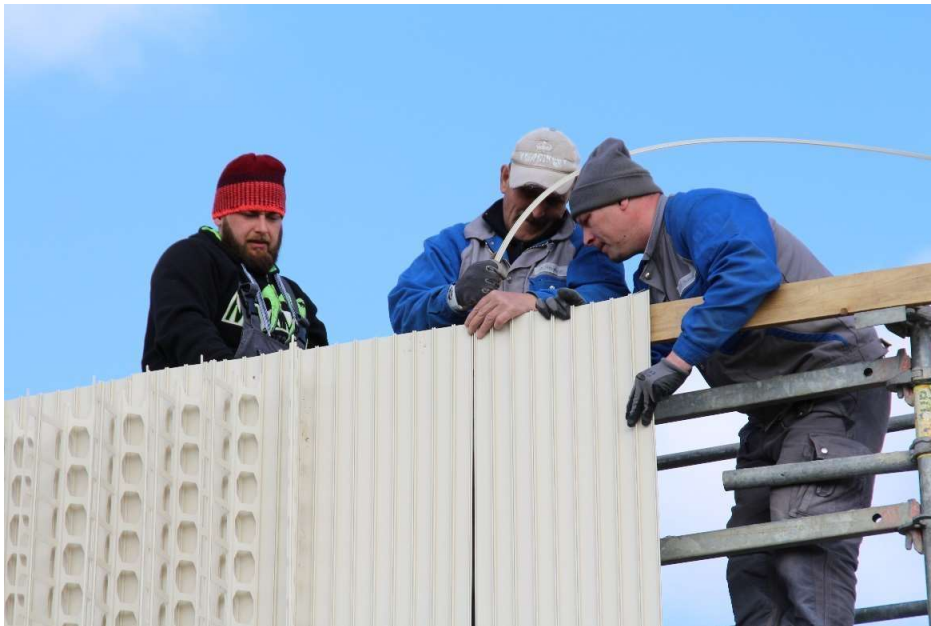
Abbildung 6. Montage Verbinder für Innenschalung
