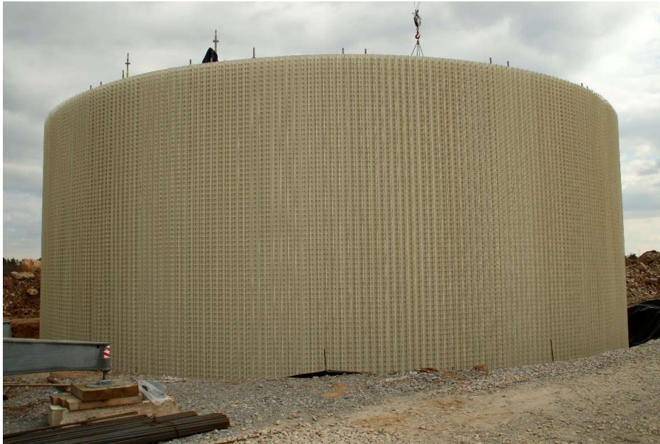
Abbildung 11. Geschlossene Innenschalung
