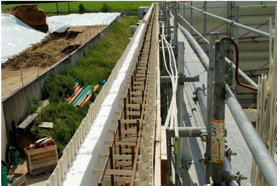
Abbildung 22. Aufbau einer geraden Wand
