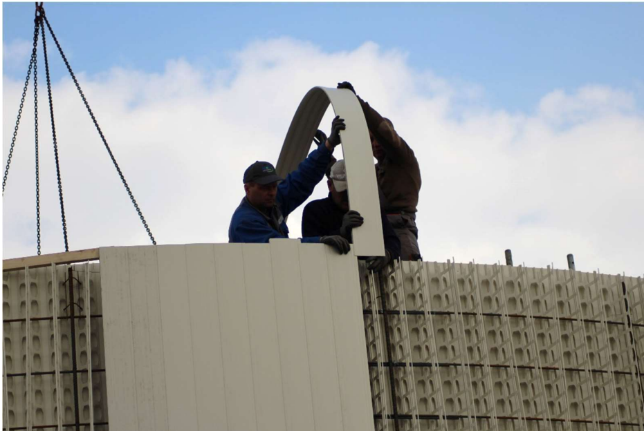
Abbildung 16. Montage der Außenpaneele
