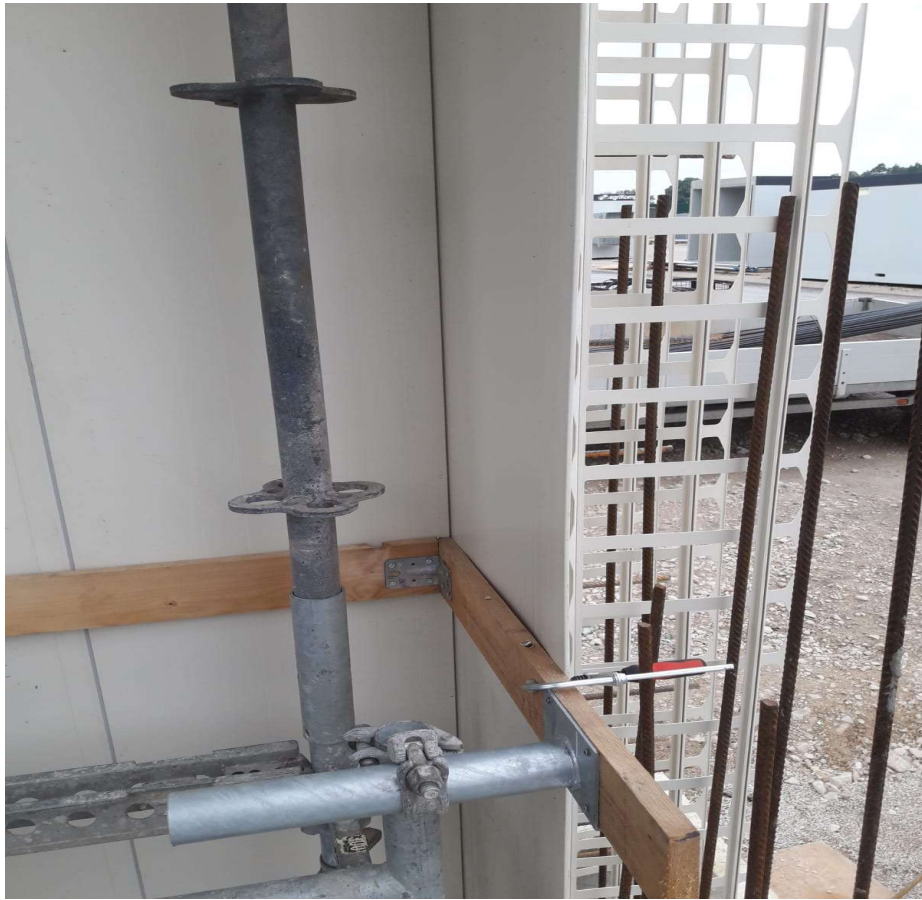
Abbildung 24. Aufbau von Ecken
