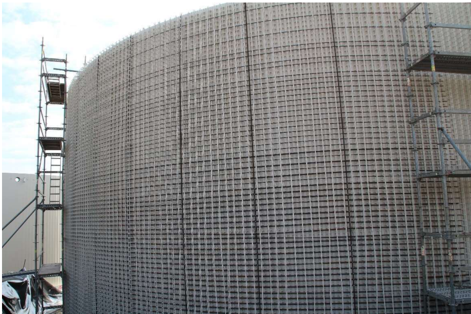
Abbildung 14. Fertig armierte Behälterwand
