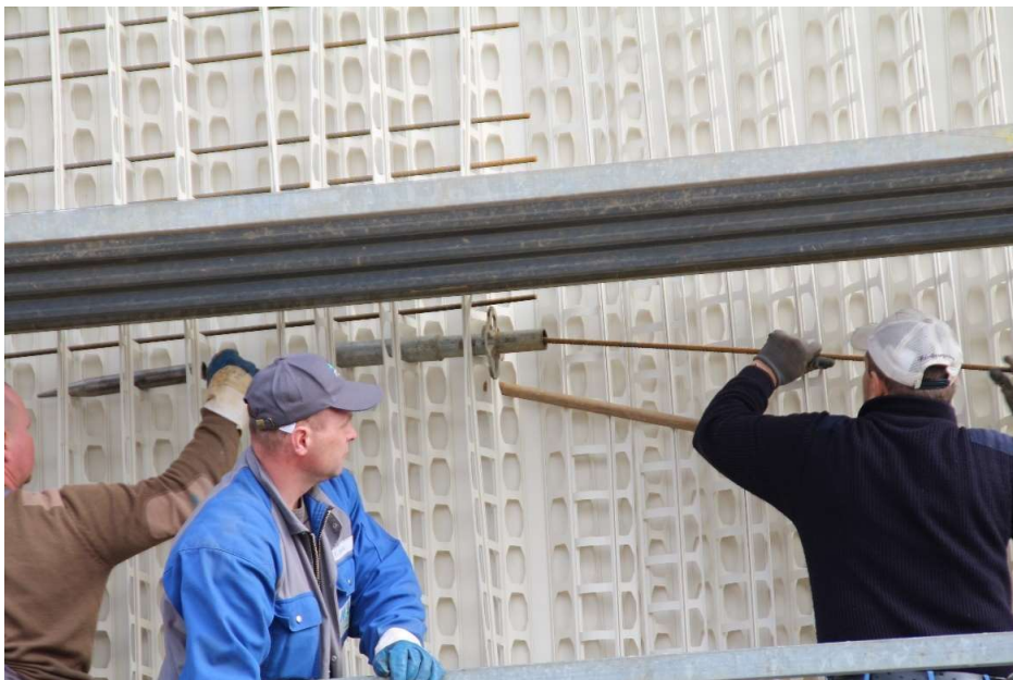
Abbildung 12. Einschieben der horizontalen Bewehrungsstäbe
