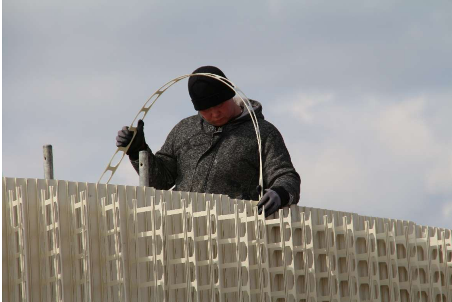
Abbildung 9. Montage 45° Versteifungen
