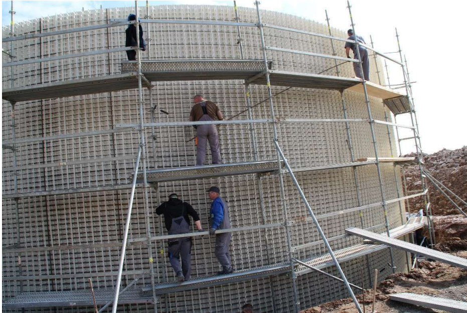
Abbildung 13. Montage der vertikalen Bewehrungsstäbe
