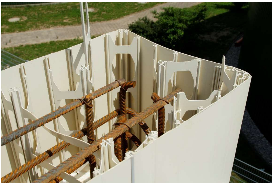
Abbildung 23. Ausführung der Wandenden
