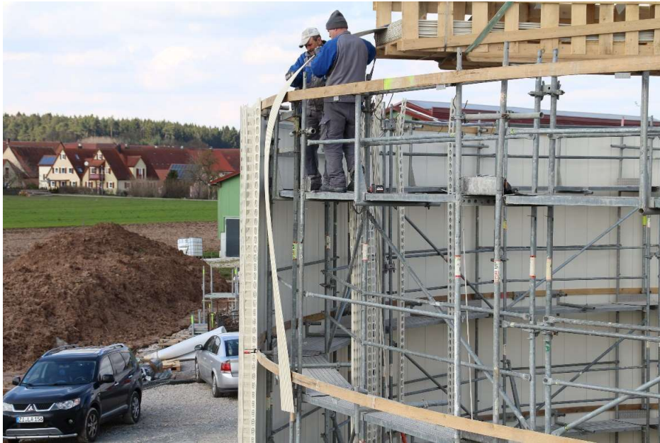
Abbildung 5. Montage Innenschalung
