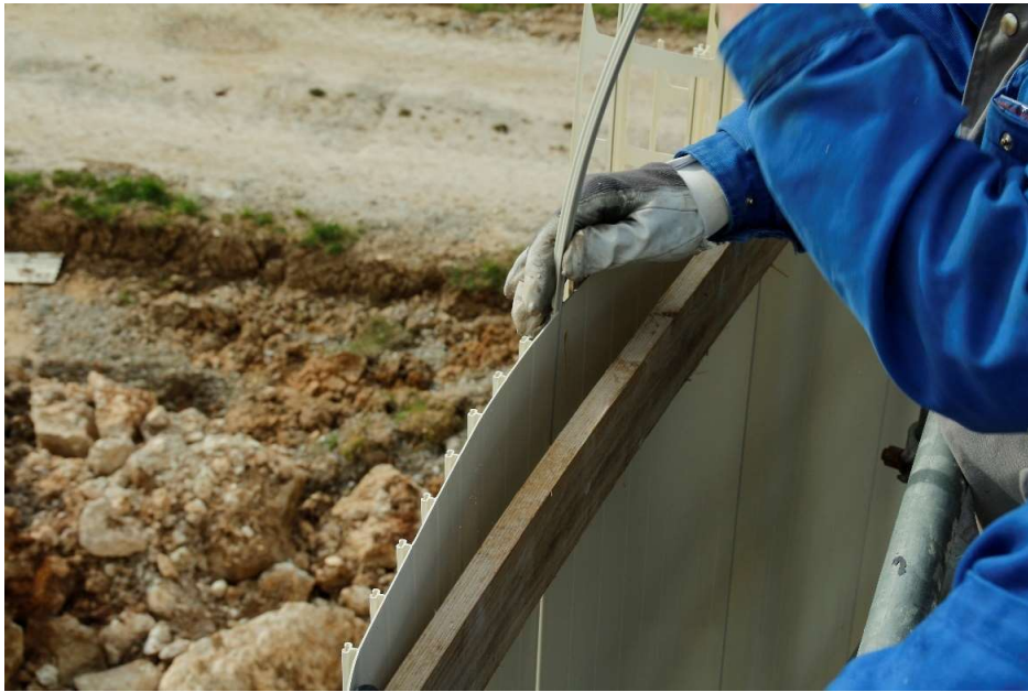
Abbildung 7. Montage Verbinder für Innenpaneele
