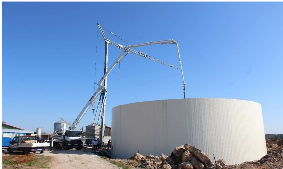
Abbildung 21. Befüllung der Schalung mit Beton
