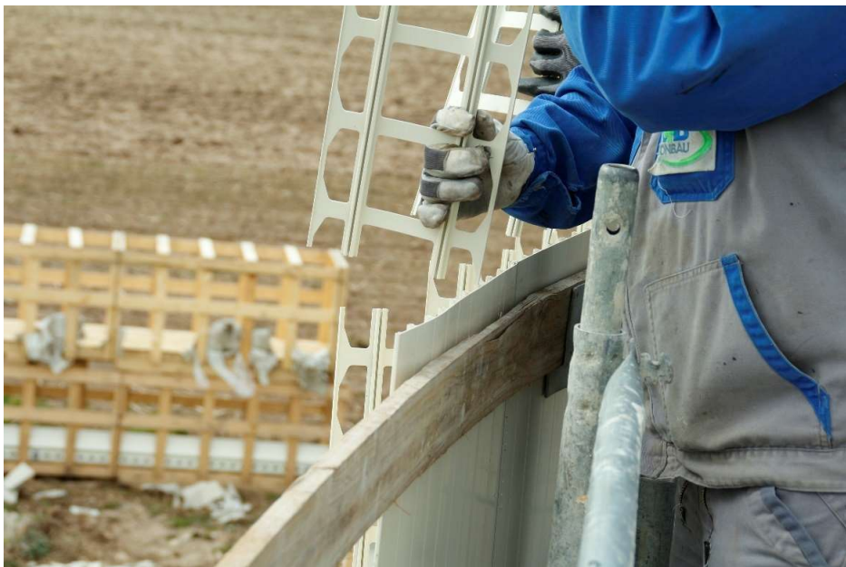
Abbildung 8. Montage Konnektoren
