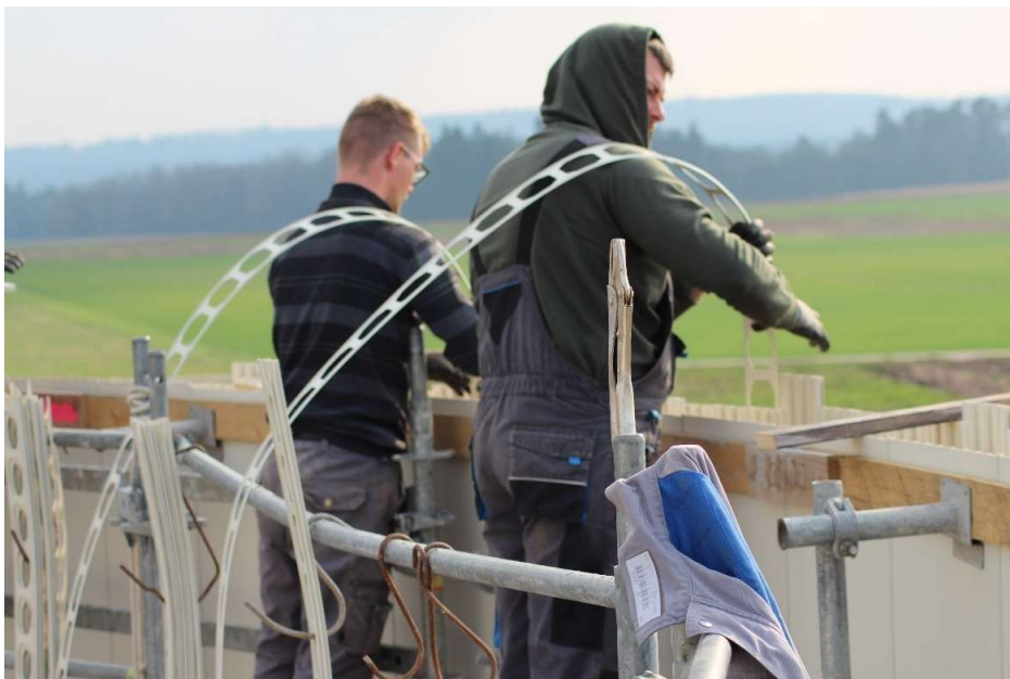
Abbildung 17. Montage 45° Versteifungen an Außenpaneelen
